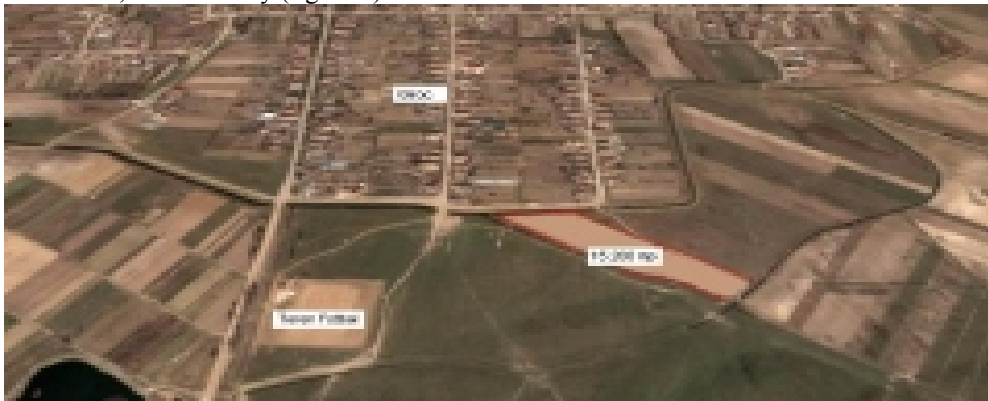
Fig. 3.1 Giroc commune overview
